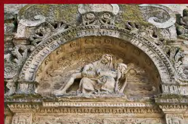
Portale Torre Campanaria
